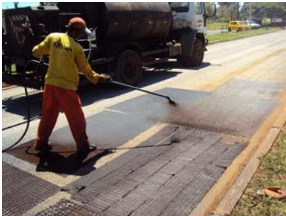
Figura 2. Aplicação da emulsão asfáltica no campo
